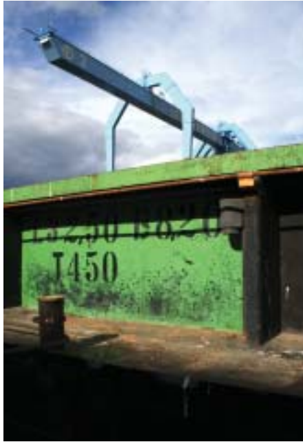
22 Kran in Lauerstellung
